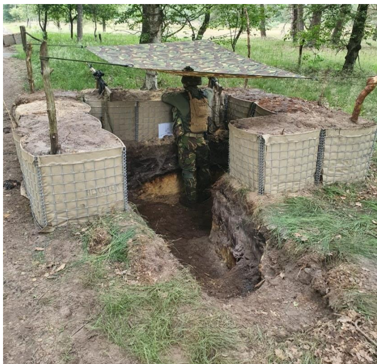
Figuur 7-33: Voorbeeld waarnemings- of wachtpost met 6x MIL2 hesco's (61x61x122 cm)
